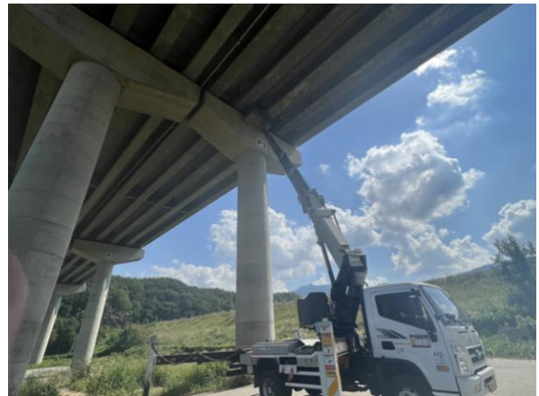
고소점검차를 이용한 근접조사
