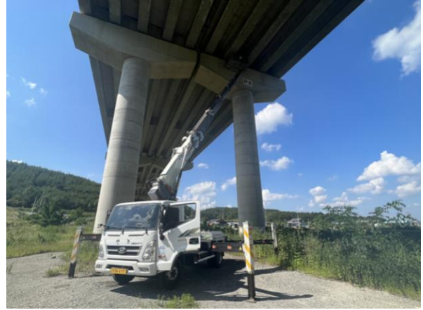
고소점검차를 이용한 근접조사
